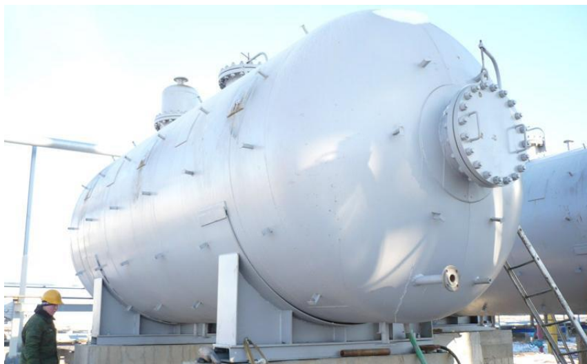
1.4 Сурет – Көлденең сепаратордың жалпы көрінісі
